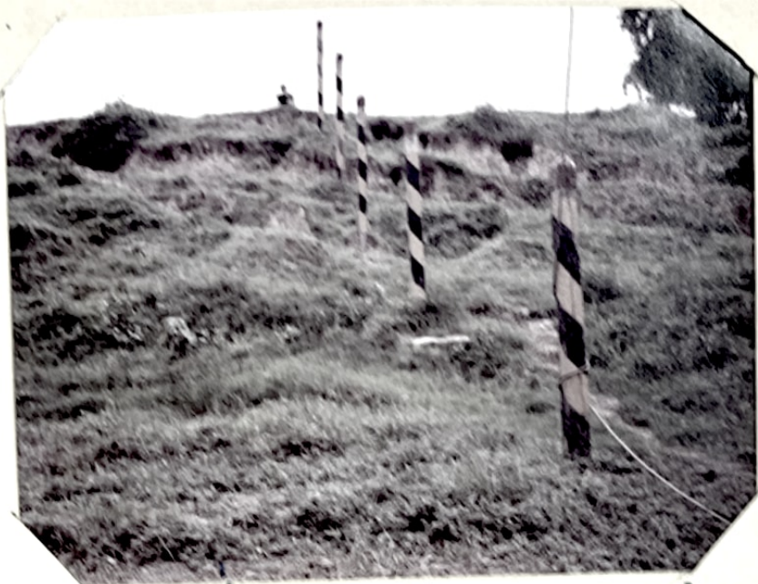
ตลิ่งฝั่ง L.B แนวสำรวจและแนวสำ.๕๑๔
